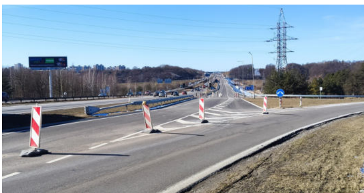
Remontuojamas A. Meškinio (Klebonišio) tiltas
