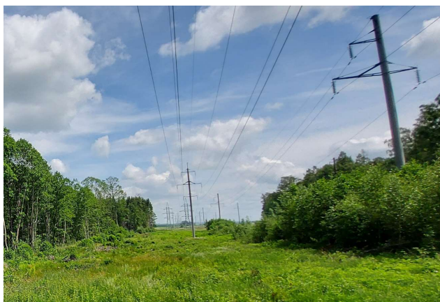
2 110 kV linijos Pagėgiai–Bitėnai statyba
