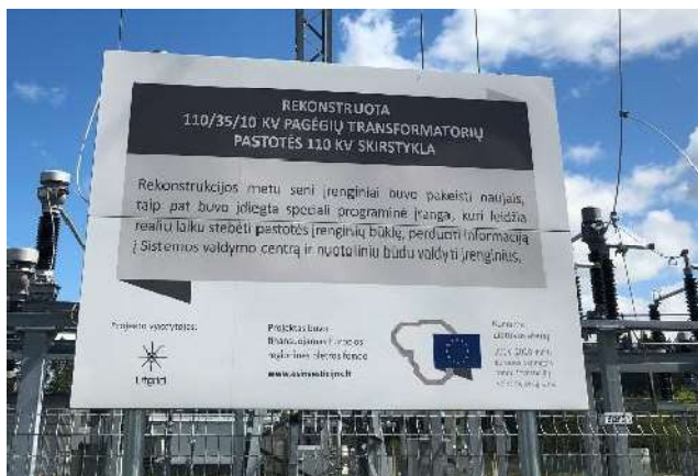
1 330 kV Bitėnų skirstyklos išplėtimas į transformatorių pastotę
